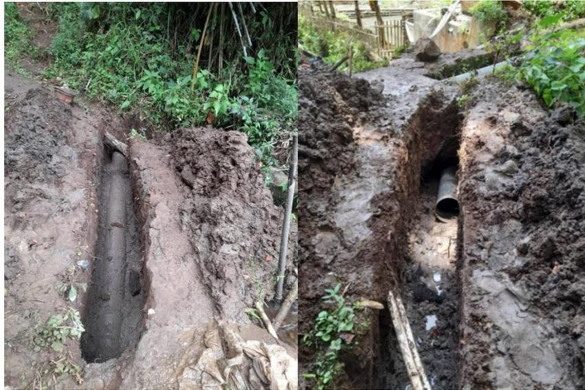
**Gambar 2.** Pembuatan Saluran Drainase Lahan.
